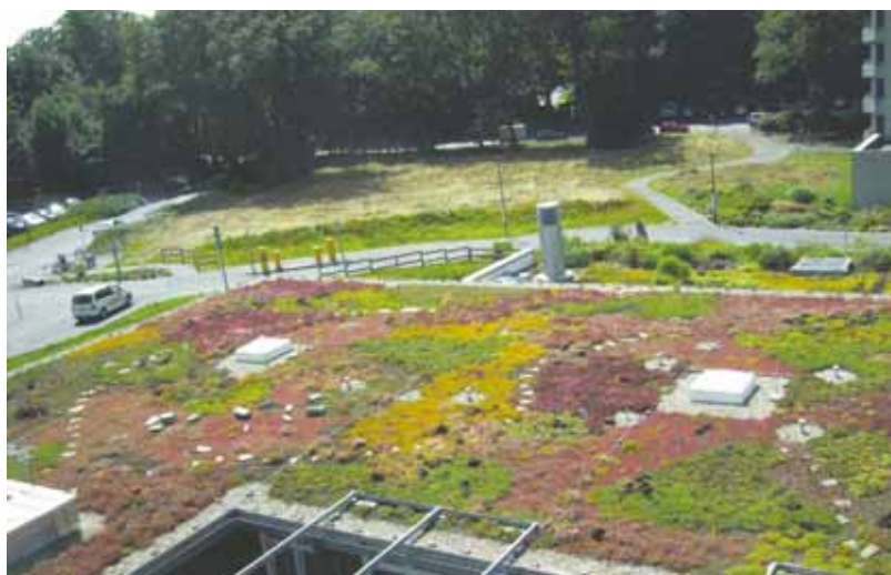
Blick auf das Dach des Gebäudes L im Krankenhaus St. Franziskus.
