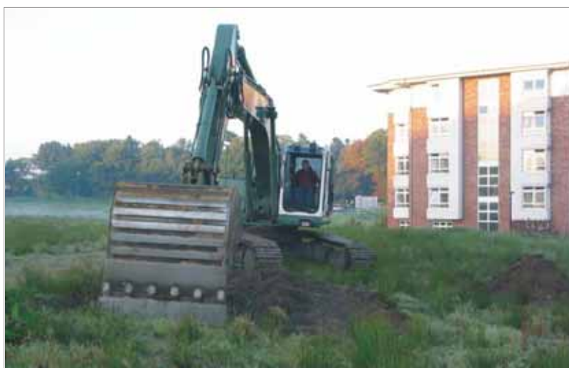
Beginn der Bauarbeiten
