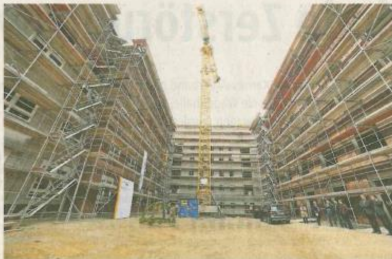
In nur zehn Monaten Bauzeit entstand der Rohbau für die beiden neuen Bettenhäuser. Die Fertigstellung ist für Frühjahr 2018 geplant. Fotos: Hans-Peter Reichartz
