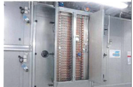
SEW-Wärmetauscher können in jedes Lüftungsgerät integriert werden. Da der Temperaturexaustausch in einer Vielzahl von Wärmetauscher-Schichten stattfindet, gewährleistet die Technologie eine hohe Betriebssicherheit.
