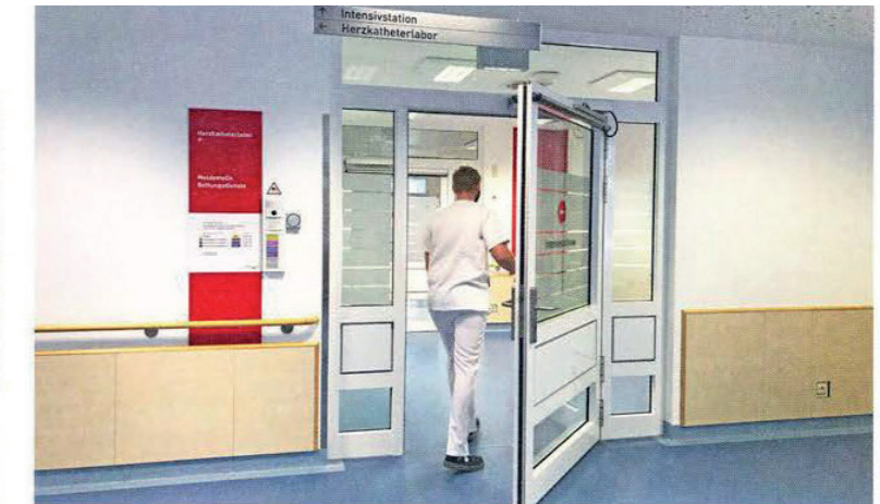
Mehr Sicherheit im Klinik-Alltag: insbesondere bei Funktionstrakten wie OPs, Endoskopie oder das Herzkatheter-Labor, daneben Ambulanzen oder – wie hier im Bild – der Intensivstation
